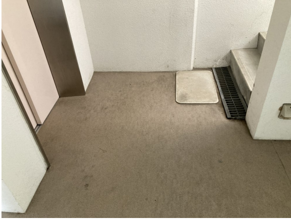
4.EV・ホール
