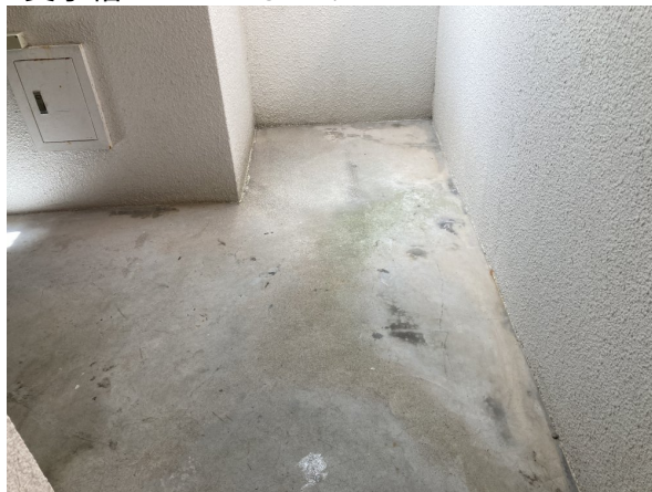
2. 受水槽フェンスまわり
