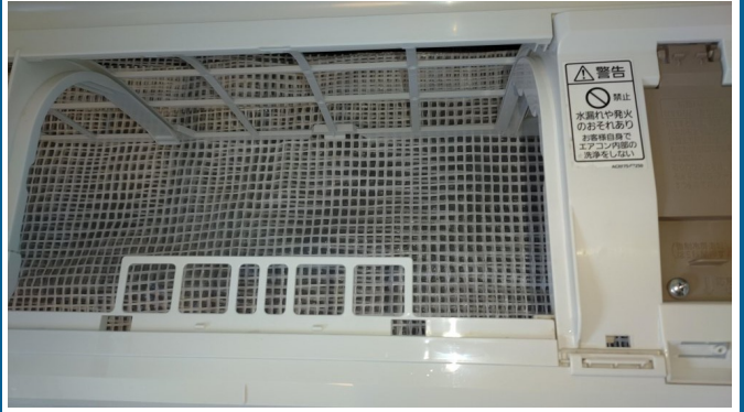
15.エアコンクリーニング
