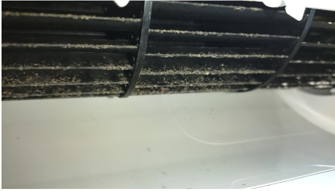
15.エアコンクリーニング
