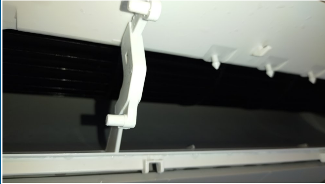
15.エアコンクリーニング
