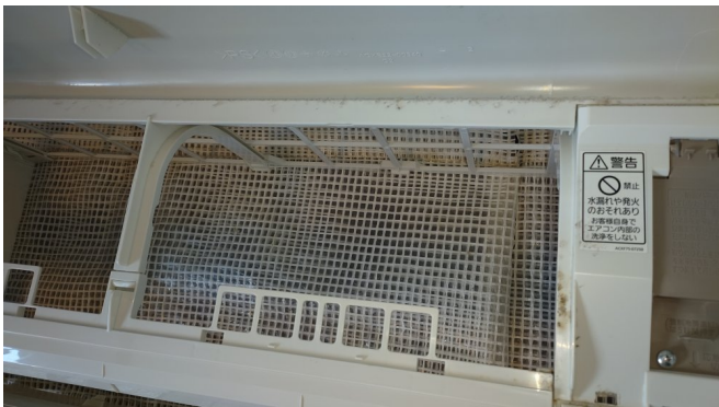
15.エアコンクリーニング
