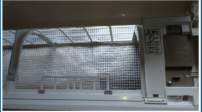
15.エアコンクリーニング
