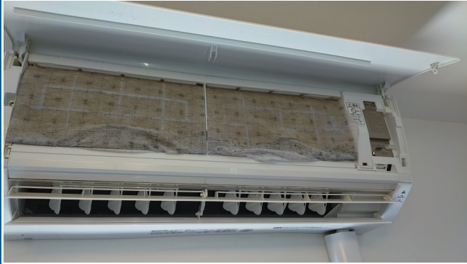
15.エアコンクリーニング
