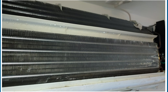
15.エアコンクリーニング
