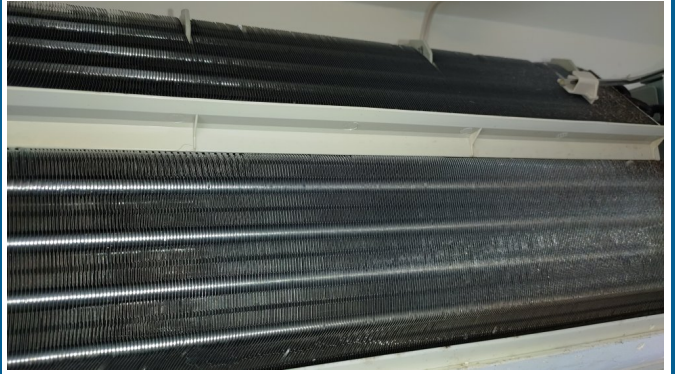
15.エアコンクリーニング
