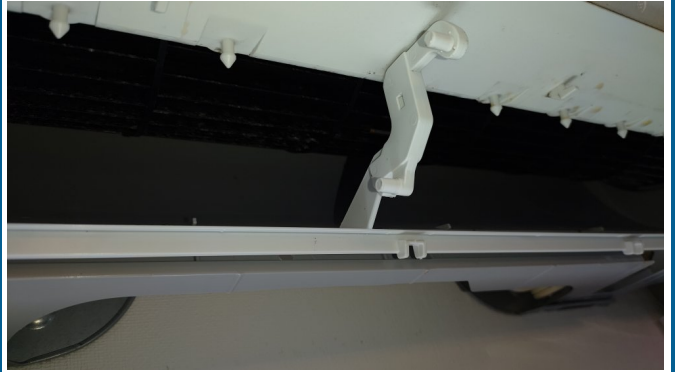
15.エアコンクリーニング
