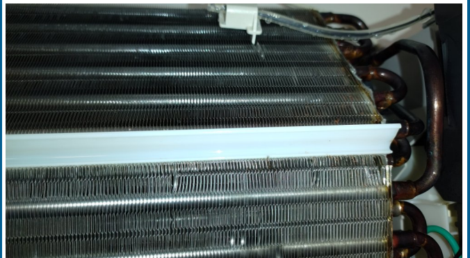
15.エアコンクリーニング
