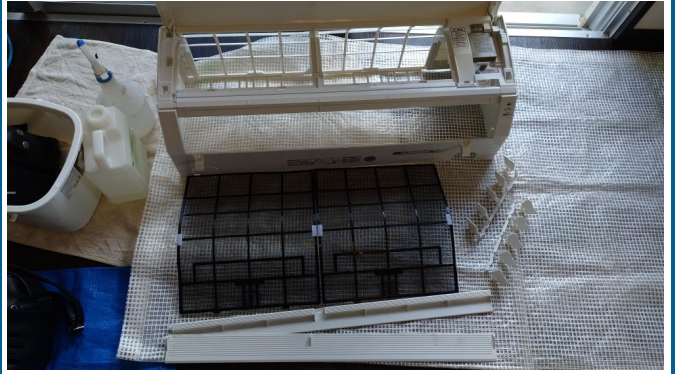
15.エアコンクリーニング
