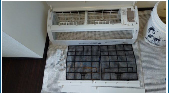
15.エアコンクリーニング
