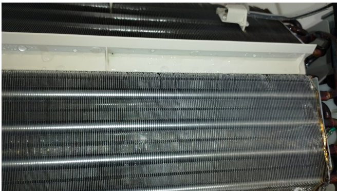
15.エアコンクリーニング
