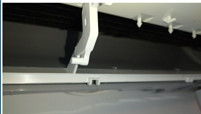
15.エアコンクリーニング
