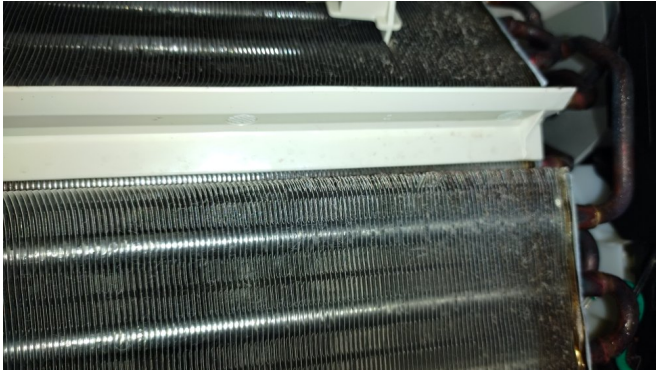
15.エアコンクリーニング
