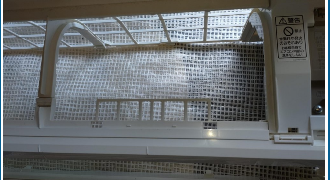
15.エアコンクリーニング
