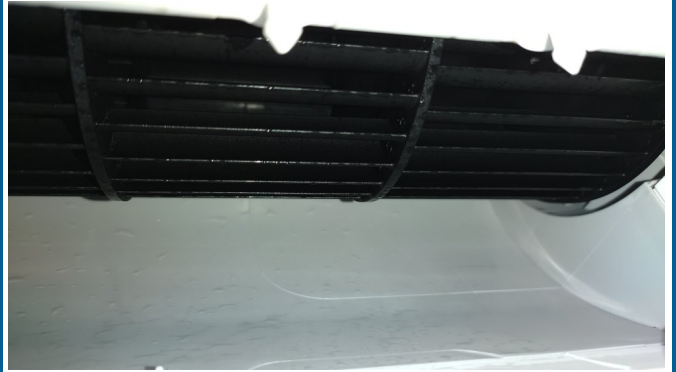
15.エアコンクリーニング
