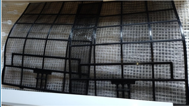
15.エアコンクリーニング
