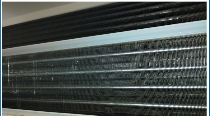
15.エアコンクリーニング
