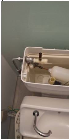
トイレタンクボールタップ取替
