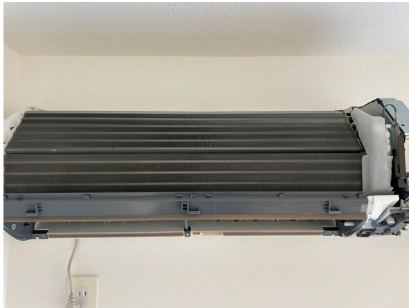
14.エアコンクリーニング
