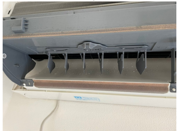
14.エアコンクリーニング
