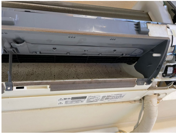
17.エアコンクリーニング
