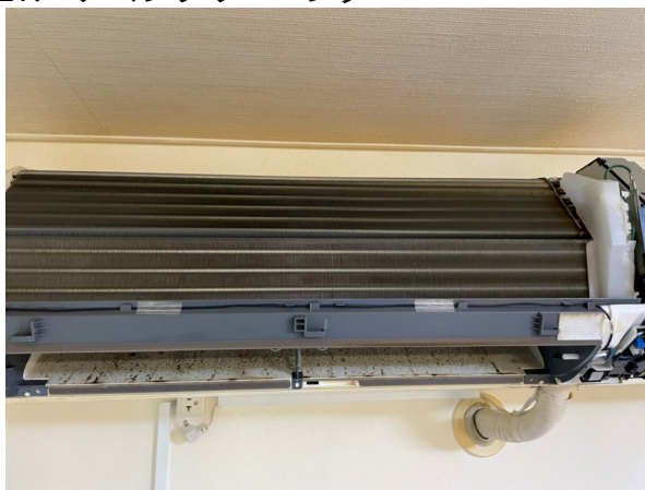
17.エアコンクリーニング
