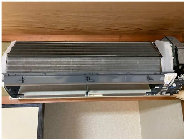
17.エアコンクリーニング
