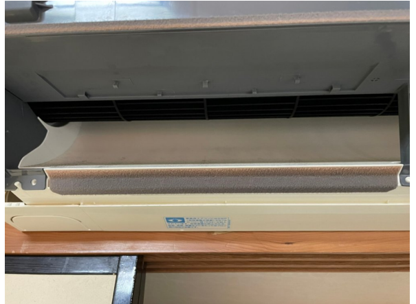
17.エアコンクリーニング
