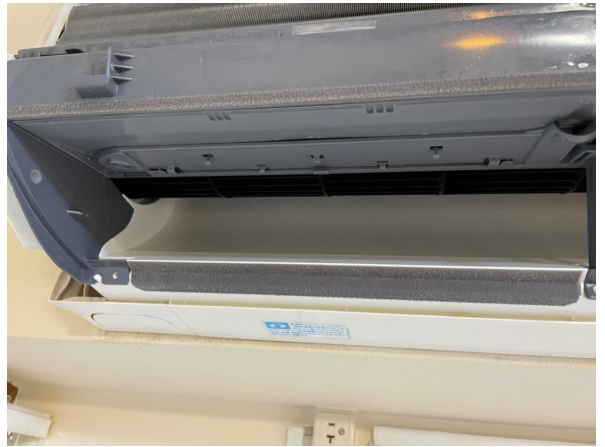
17.エアコンクリーニング
