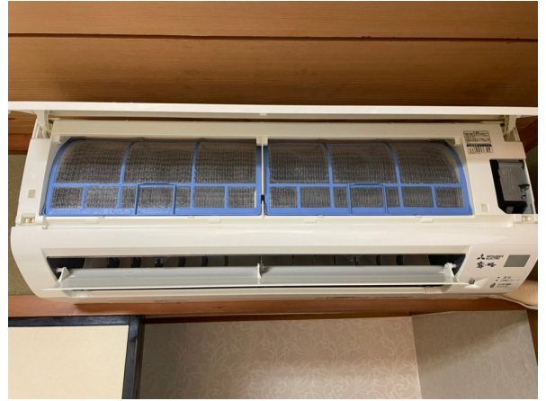
17.エアコンクリーニング
