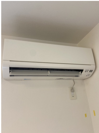
18.エアコンクリーニング
