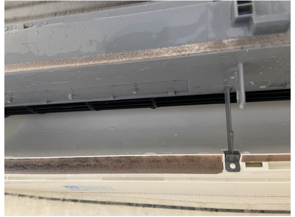
18.エアコンクリーニング
