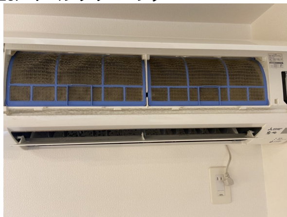
18.エアコンクリーニング
