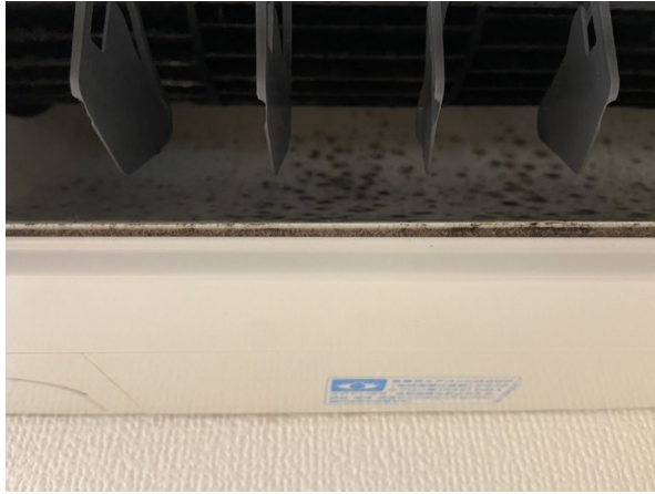
18.エアコンクリーニング
