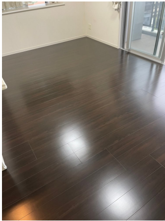
17.床剥離洗浄after
