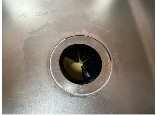
キク蓋、破損してます。
