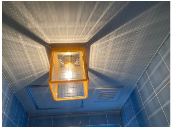
トイレ換気扇取替済み
