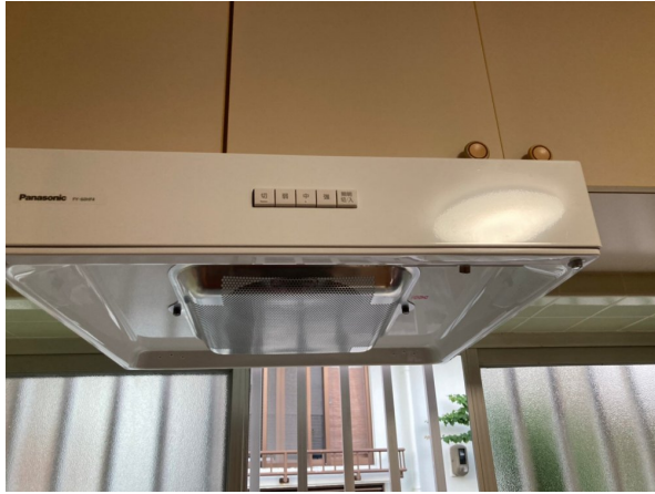
レンジフード取替
