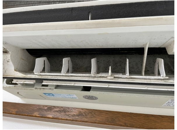
11.エアコンクリーニング
