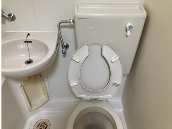
排水パイプ取替済み
