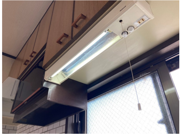
蛍光灯取替済み
