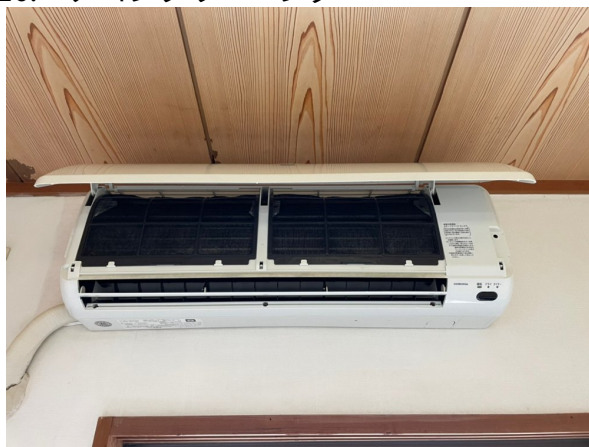
16.エアコンクリーニング
