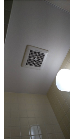
トイレ天井クロス張替済み
