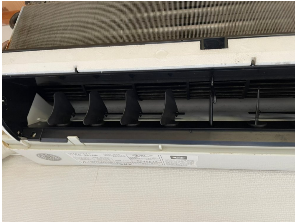
16.エアコンクリーニング
