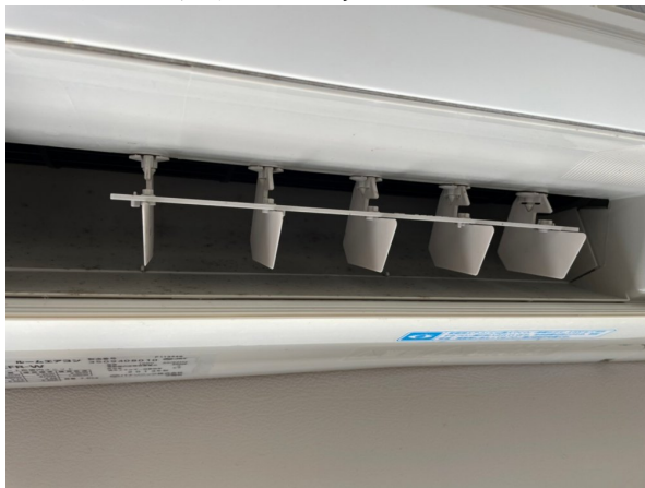
14.エアコンクリーニング
