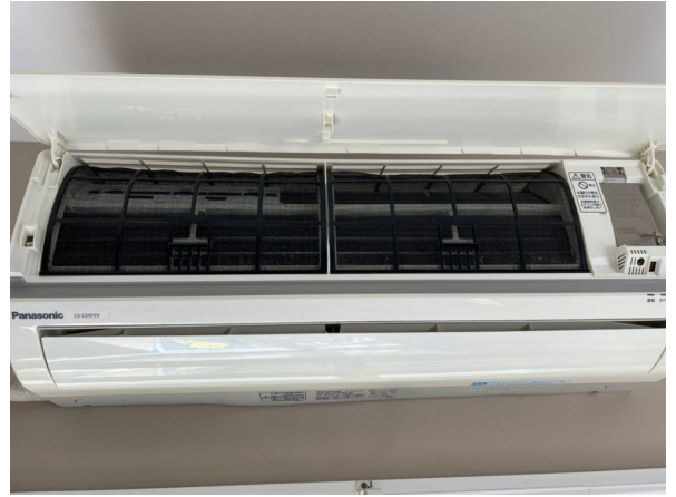
14.エアコンクリーニング
