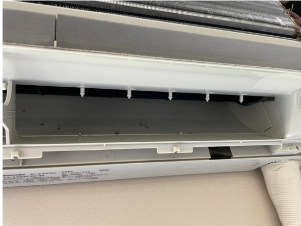
14.エアコンクリーニング
