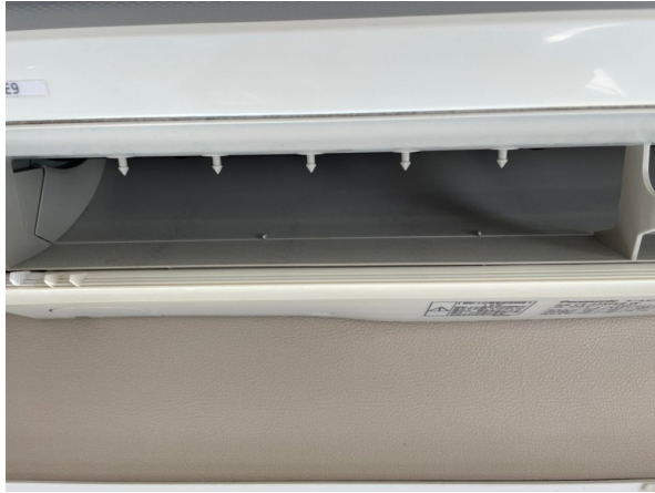
14.エアコンクリーニング
