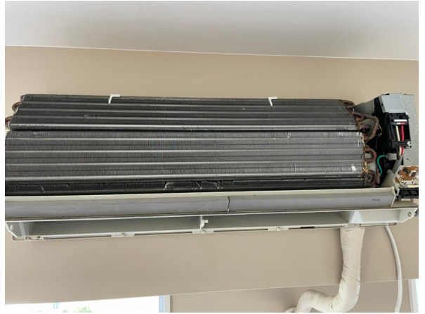
14.エアコンクリーニング
