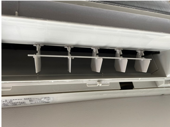
14.エアコンクリーニング
