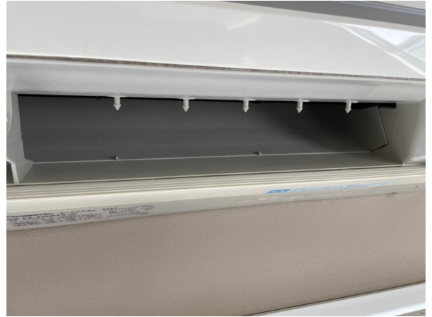
14.エアコンクリーニング
