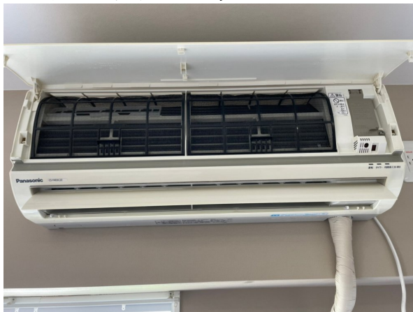
14.エアコンクリーニング
