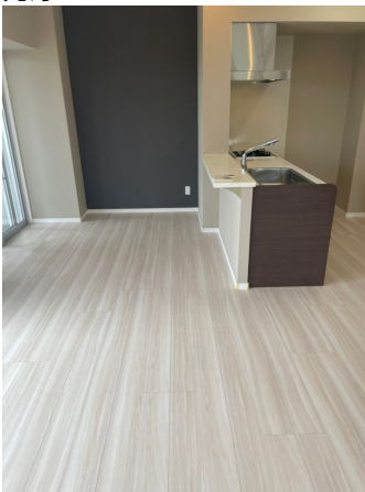
20.床剥離洗浄after
