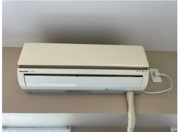
14.エアコンクリーニング
