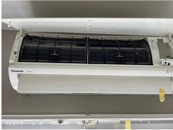
14.エアコンクリーニング
