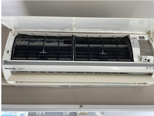
14.エアコンクリーニング
