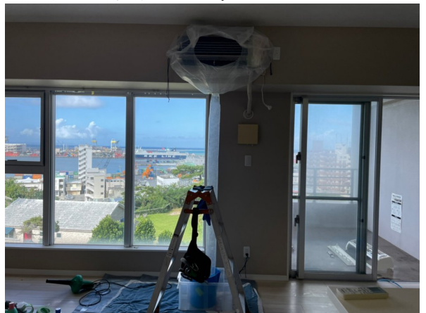
14.エアコンクリーニング
