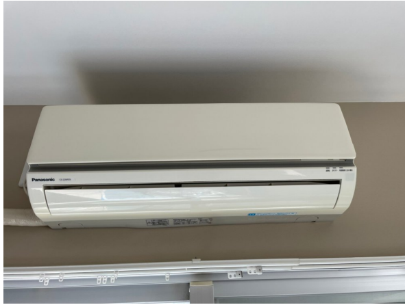
14.エアコンクリーニング
