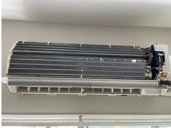
14.エアコンクリーニング
