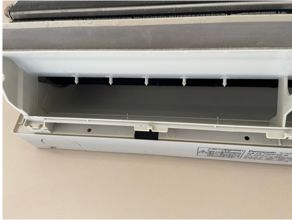
14.エアコンクリーニング
