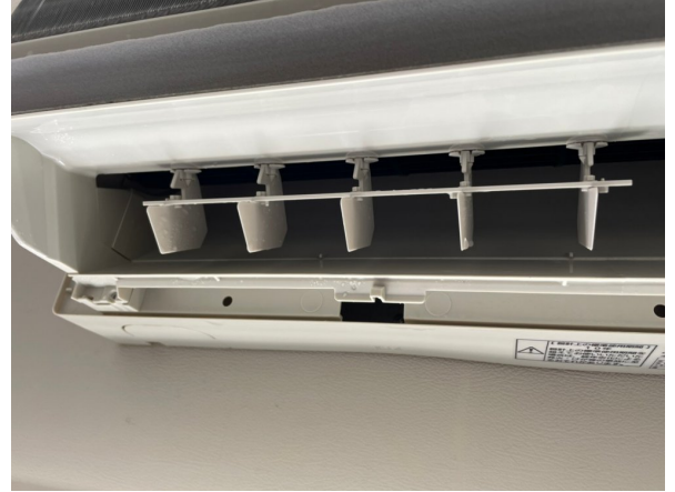
14.エアコンクリーニング
