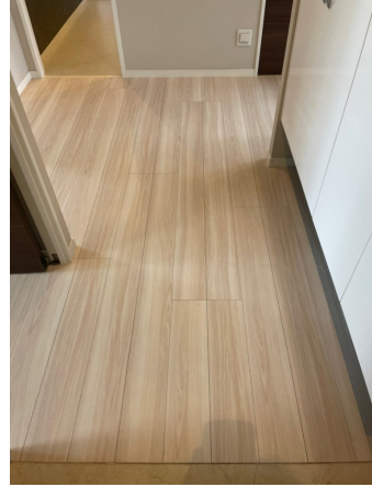
20.床剥離洗浄after
