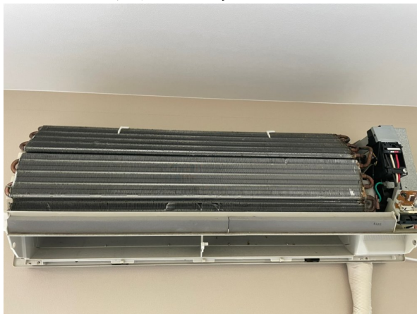
14.エアコンクリーニング
