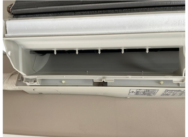
14.エアコンクリーニング
