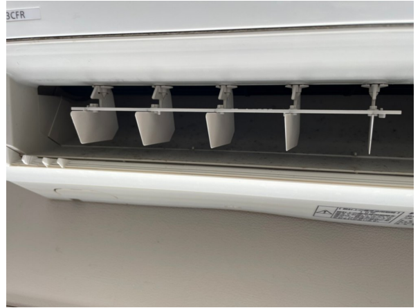
14.エアコンクリーニング
