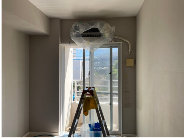
14.エアコンクリーニング
