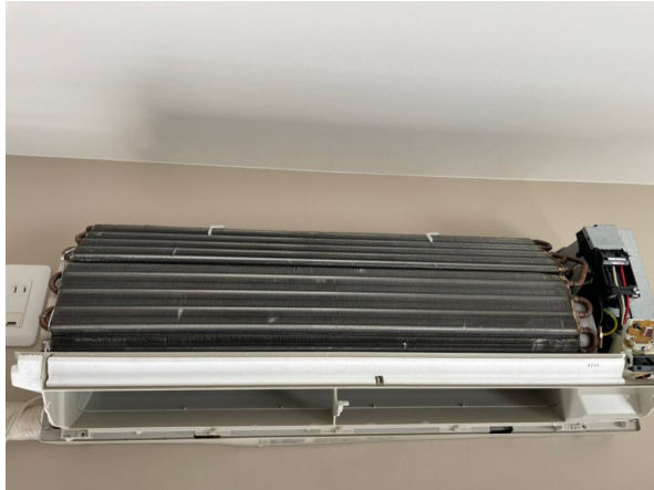
14.エアコンクリーニング
