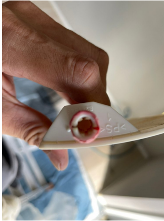
14.エアコンクリーニング
