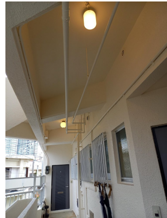
スパイラス球 電球交換済み
