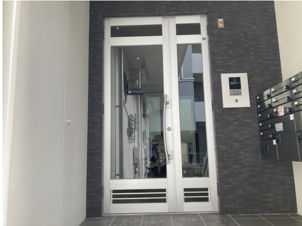
6.エントランスホール（タイル・ガラス）
