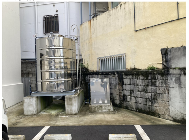
2. 受水槽フェンスまわり
