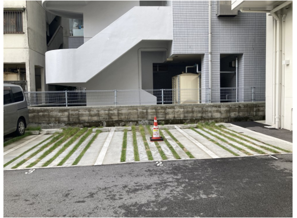
1. 駐車場・駐輪場
