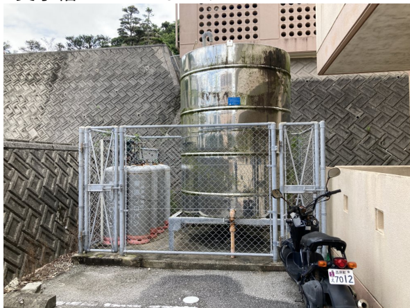
5.受水槽フェンスまわり
