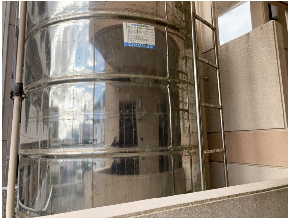
5.受水槽フェンスまわり
