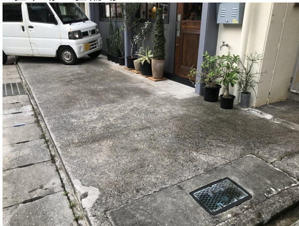
1. 駐車場・駐輪場
