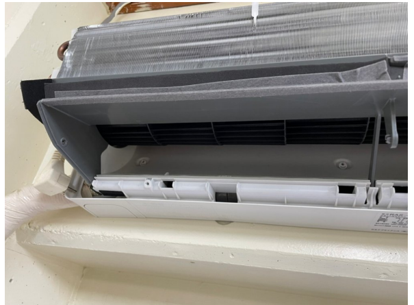
6.エアコンクリーニング
