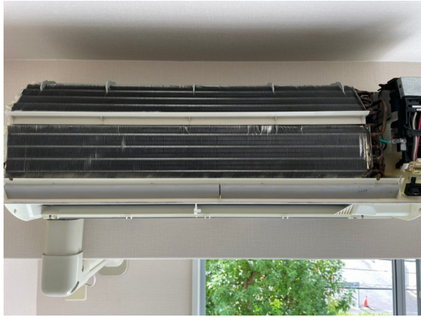
15.エアコンクリーニング
