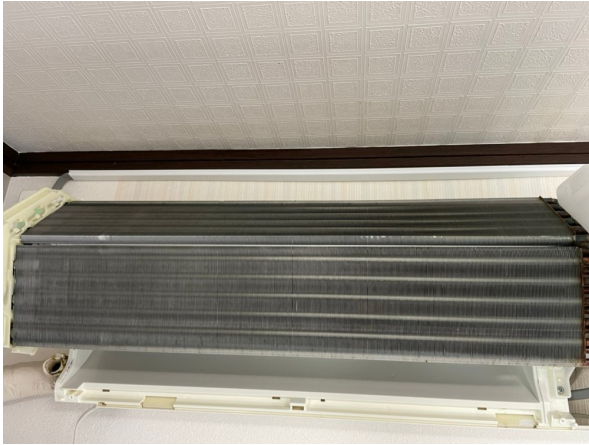
16.エアコンクリーニング
