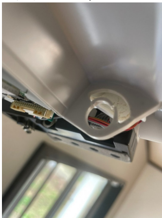
16.エアコンクリーニング
