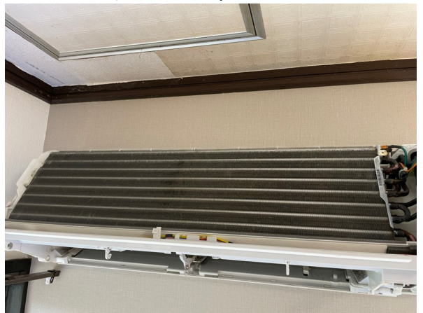
16.エアコンクリーニング
