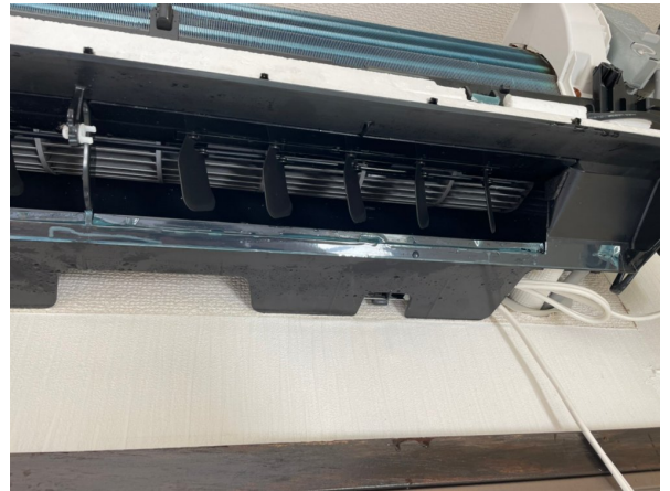
16.エアコンクリーニング
