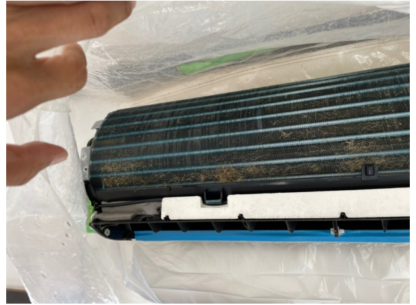
16.エアコンクリーニング
