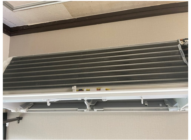
16.エアコンクリーニング
