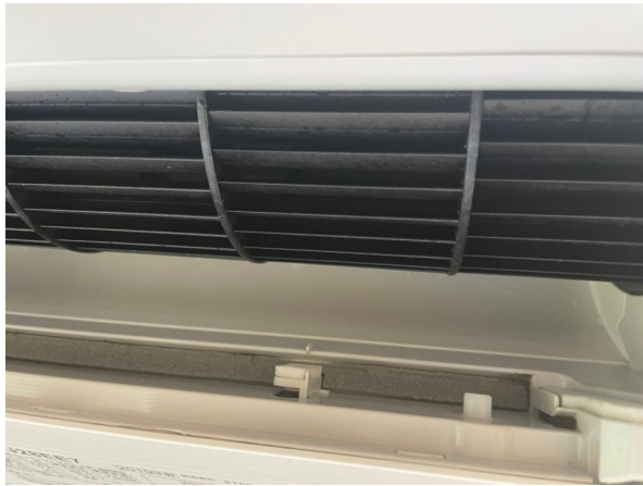
16.エアコンクリーニング
