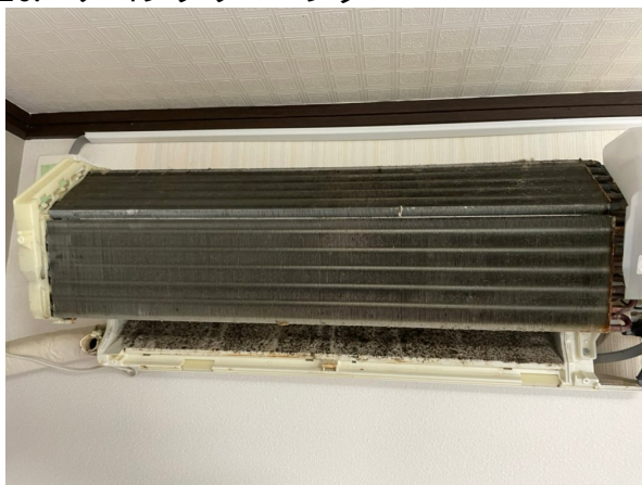
16.エアコンクリーニング
