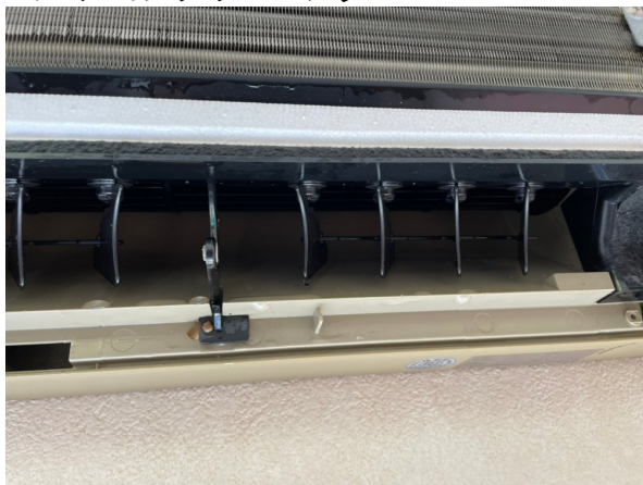
12.エアコンクリーニング
