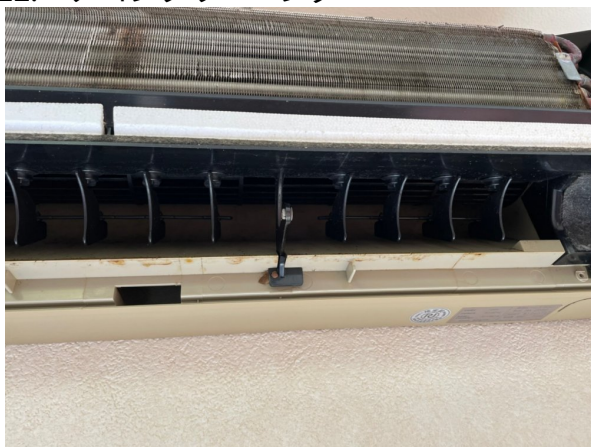
12.エアコンクリーニング
