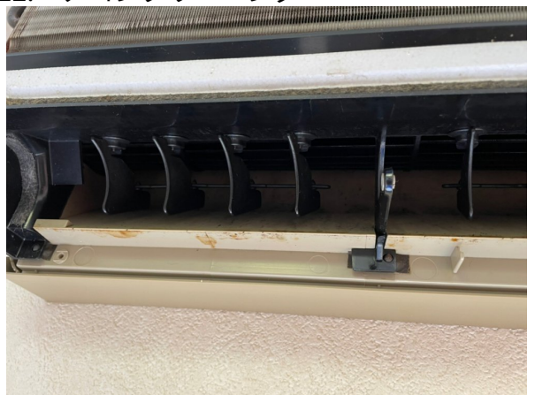
12.エアコンクリーニング
