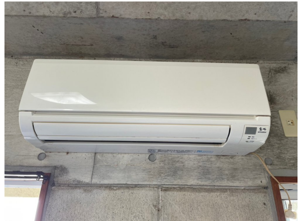
17.エアコンクリーニング
