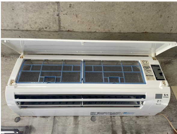
17.エアコンクリーニング
