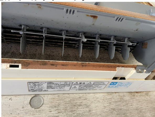
17.エアコンクリーニング
