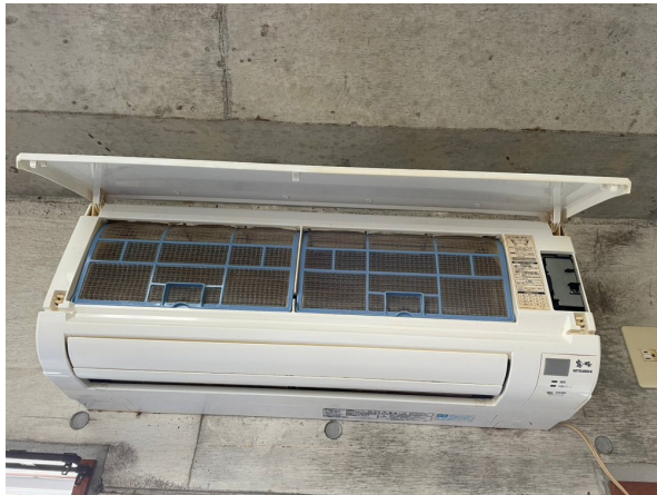
17.エアコンクリーニング
