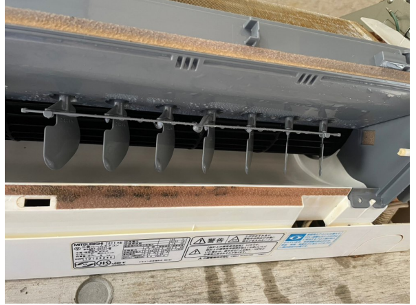
17.エアコンクリーニング
