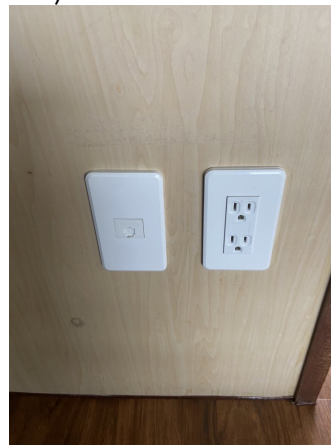
コンセント取替 2 カ所
