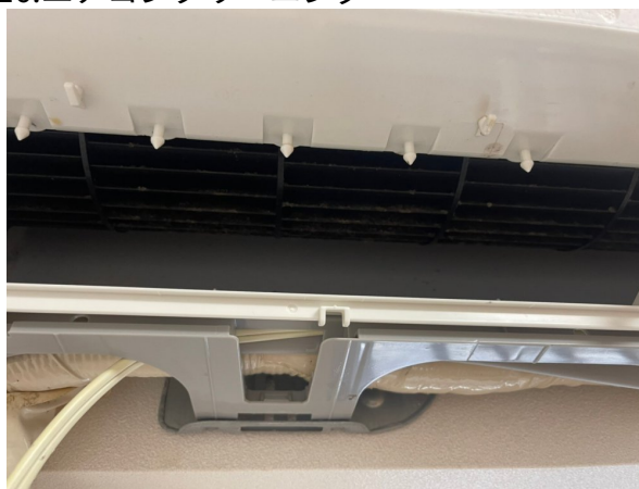
16.エアコンクリーニング
