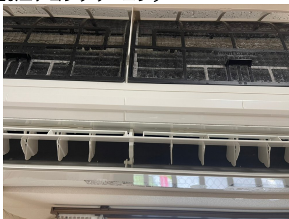
16.エアコンクリーニング
