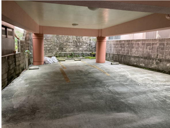
1. 駐車場・駐輪場
