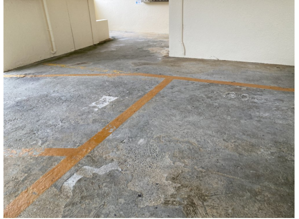
1. 駐車場・駐輪場
