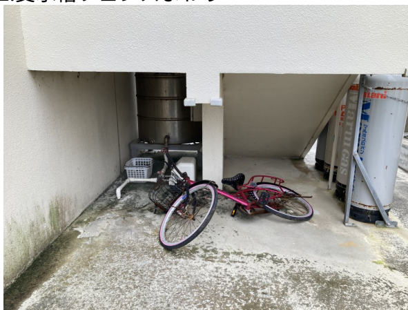
2. 受水槽フェンスまわり
