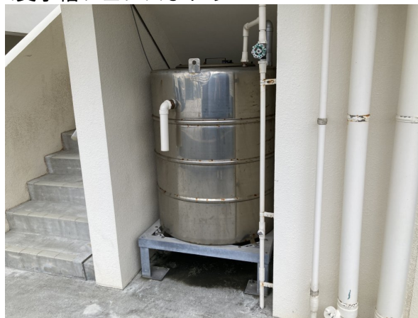
2. 受水槽フェンスまわり
