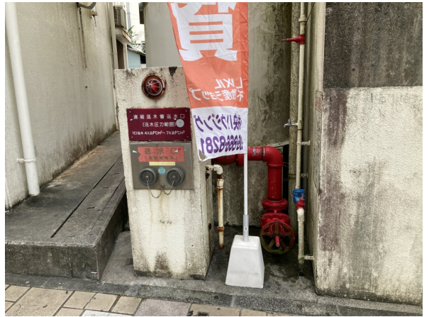
2. 受水槽フェンスまわり
