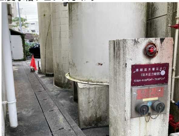
2. 受水槽フェンスまわり
