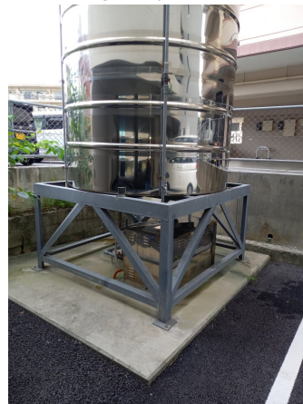
2. 受水槽フェンスまわり
