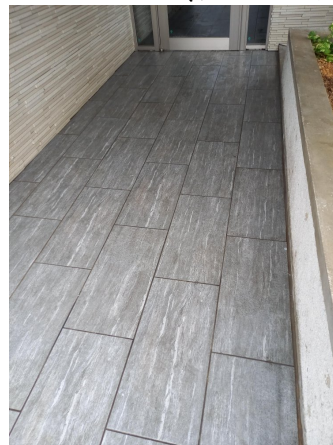
5.エントランスホール (タイル・ガラス)
