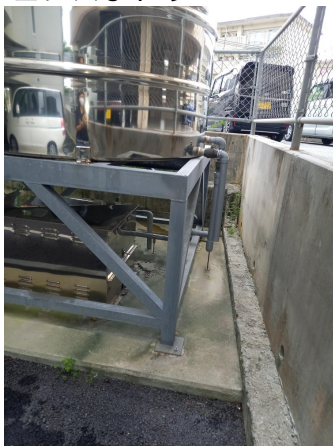
2. 受水槽フェンスまわり
