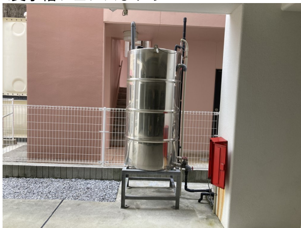
2. 受水槽フェンスまわり
