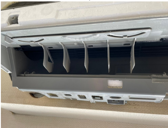
13.エアコンクリーニング
