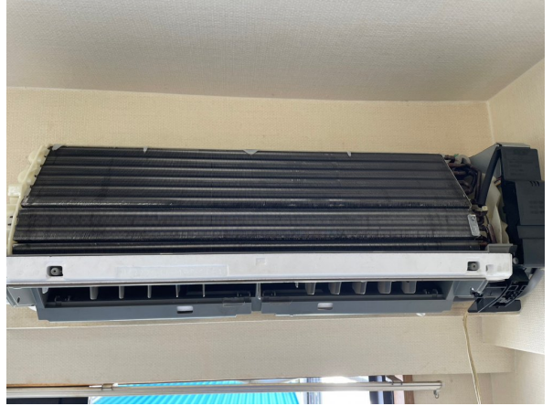
13.エアコンクリーニング
