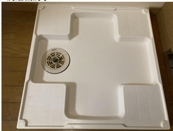
5.洗濯機防水パン
