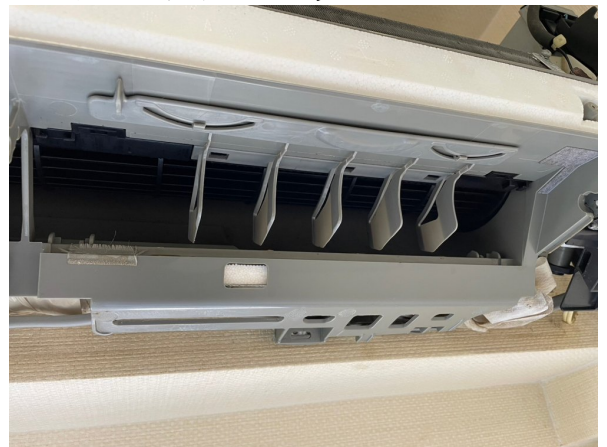
13.エアコンクリーニング
