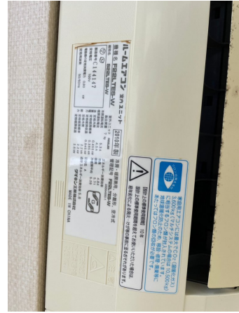
13.エアコンクリーニング
