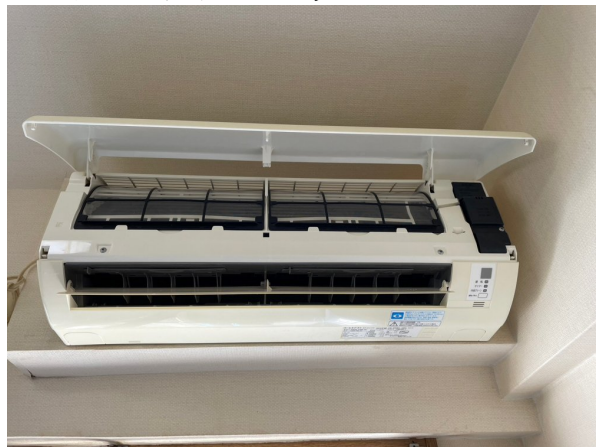
13.エアコンクリーニング
