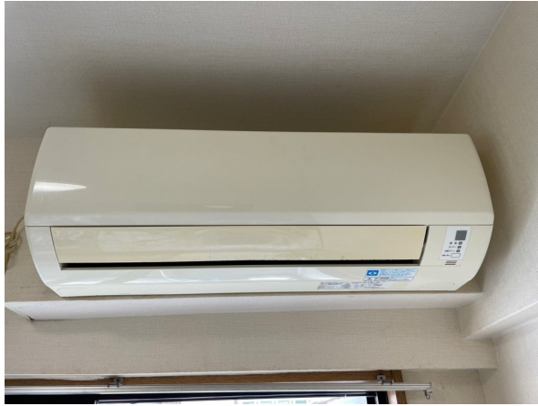
13.エアコンクリーニング
