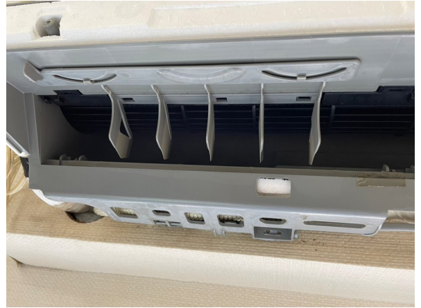
13.エアコンクリーニング
