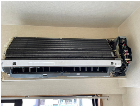
13.エアコンクリーニング
