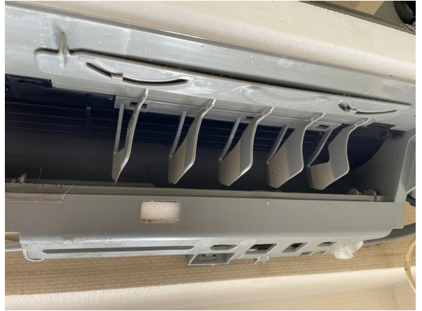
13.エアコンクリーニング
