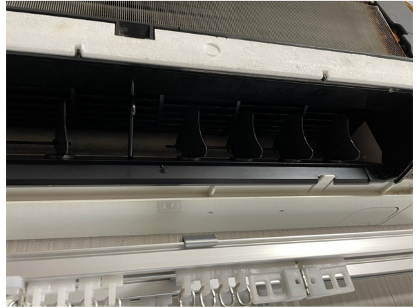
14.エアコンクリーニング
