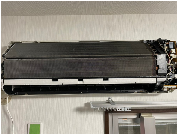
14.エアコンクリーニング
