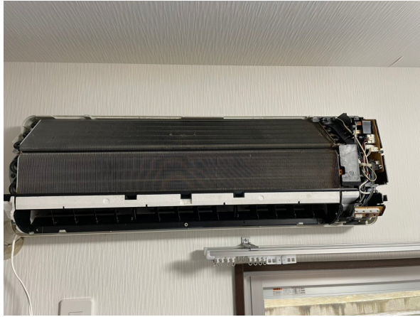
14.エアコンクリーニング
