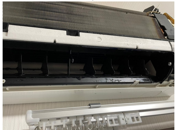
14.エアコンクリーニング
