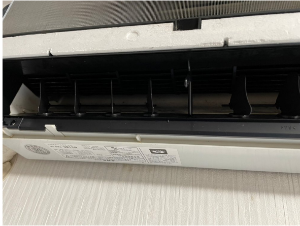
14.エアコンクリーニング
