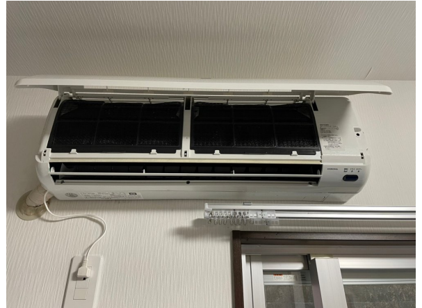
14.エアコンクリーニング
