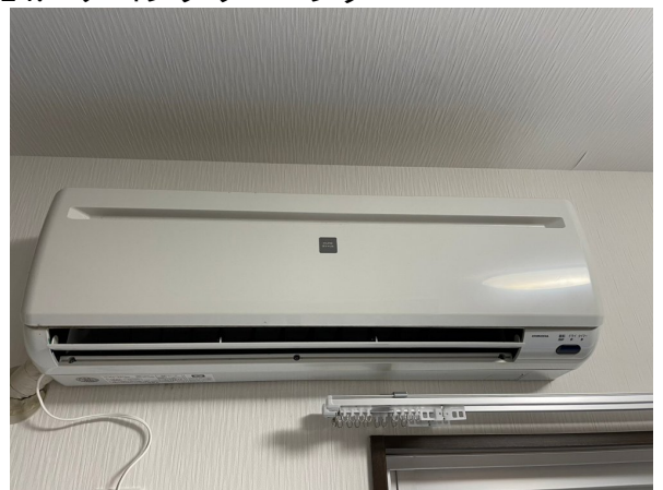
14.エアコンクリーニング
