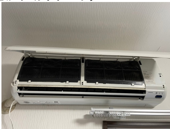
14.エアコンクリーニング
