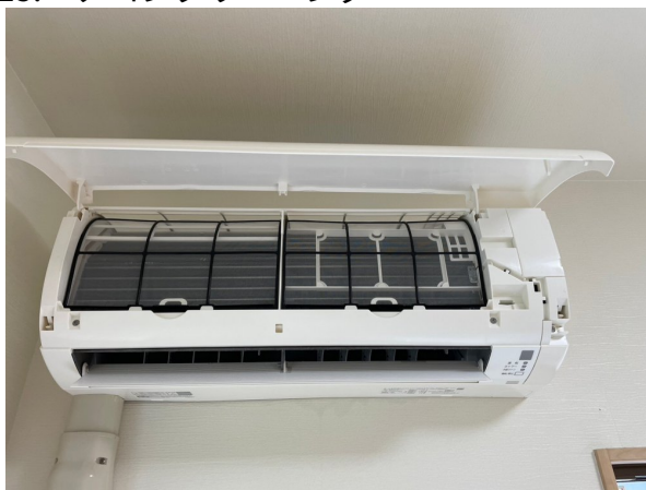
15.エアコンクリーニング
