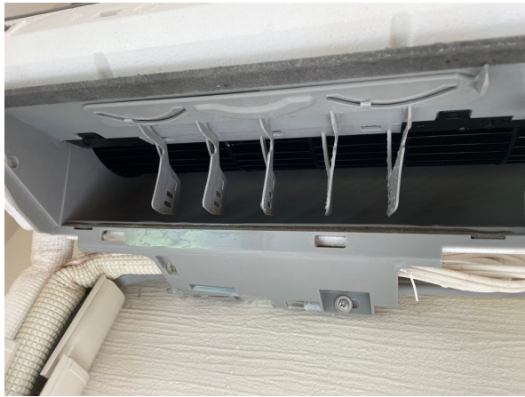
15.エアコンクリーニング
