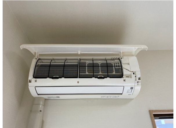
15.エアコンクリーニング
