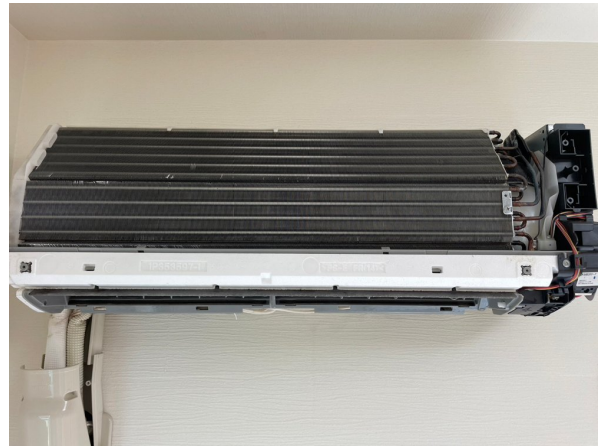
15.エアコンクリーニング
