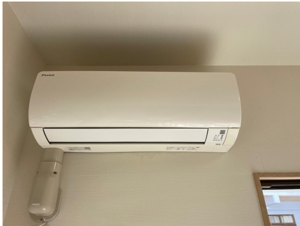
15.エアコンクリーニング
