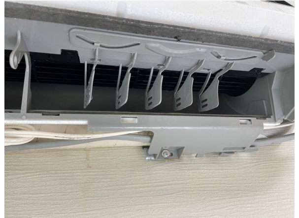
15.エアコンクリーニング
