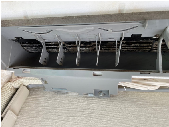
15.エアコンクリーニング
