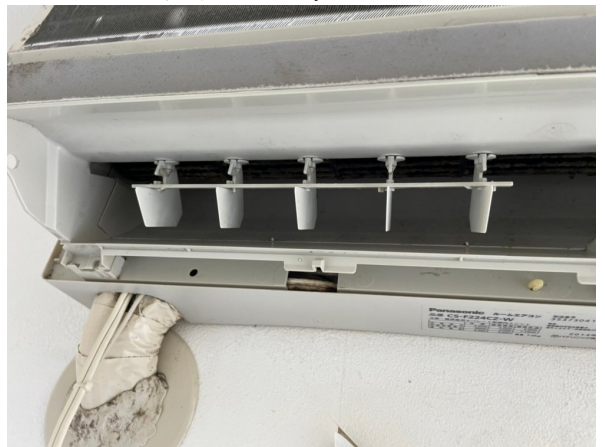
14.エアコンクリーニング
