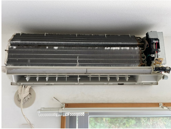
14.エアコンクリーニング
