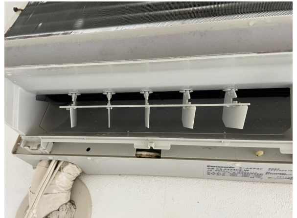
14.エアコンクリーニング
