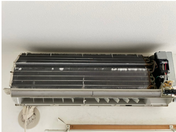
14.エアコンクリーニング
