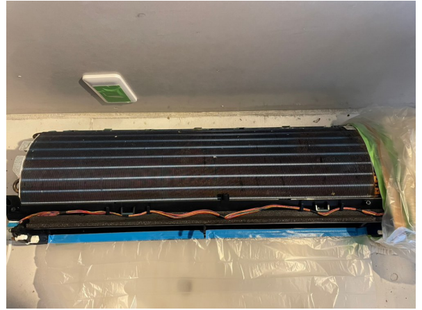
14.エアコンクリーニング
