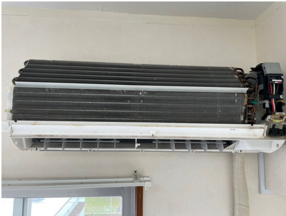
14.エアコンクリーニング
