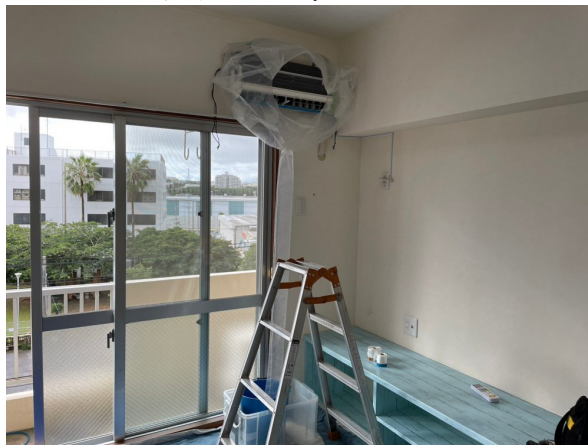
14.エアコンクリーニング
