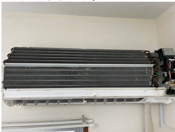
14.エアコンクリーニング
