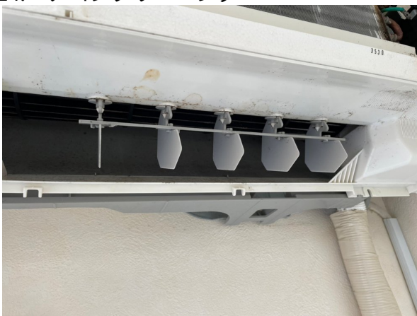
14.エアコンクリーニング
