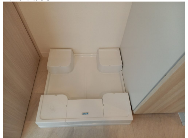
7.洗濯機防水パン
