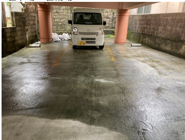
1. 駐車場・駐輪場
