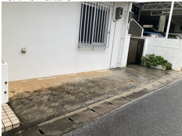
1. 駐車場・駐輪場
