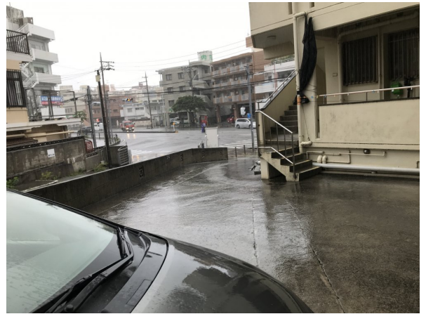
1. 駐車場・駐輪場
