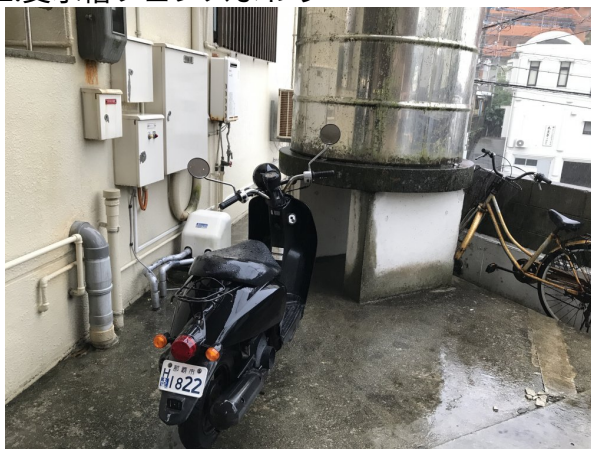
2. 受水槽フェンスまわり
