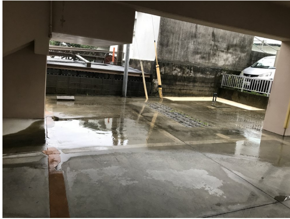
1. 駐車場・駐輪場
