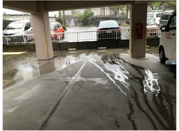
1. 駐車場・駐輪場
