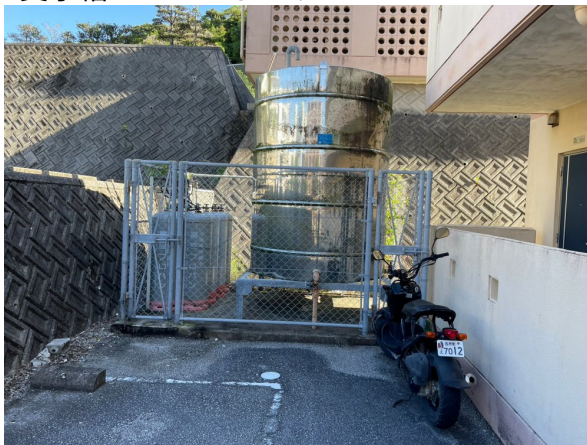
5.受水槽フェンスまわり
