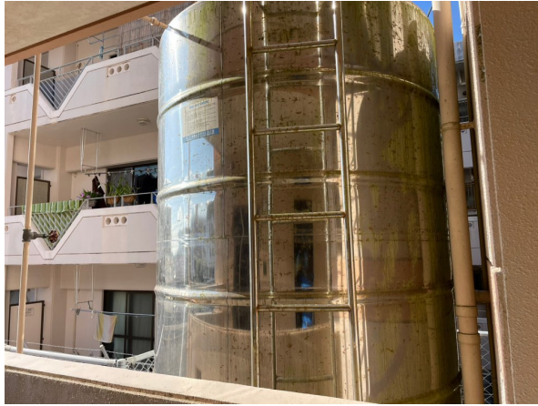
5.受水槽フェンスまわり
