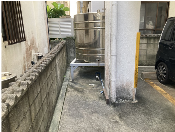
2. 受水槽フェンスまわり
