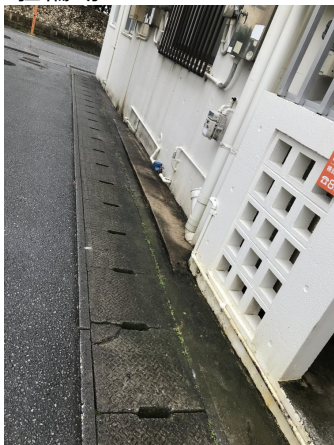
1. 駐車場・駐輪場
