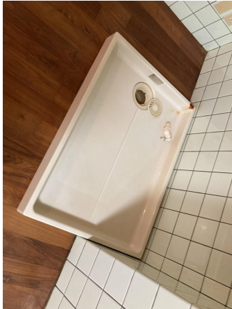
5.洗濯機防水パン
