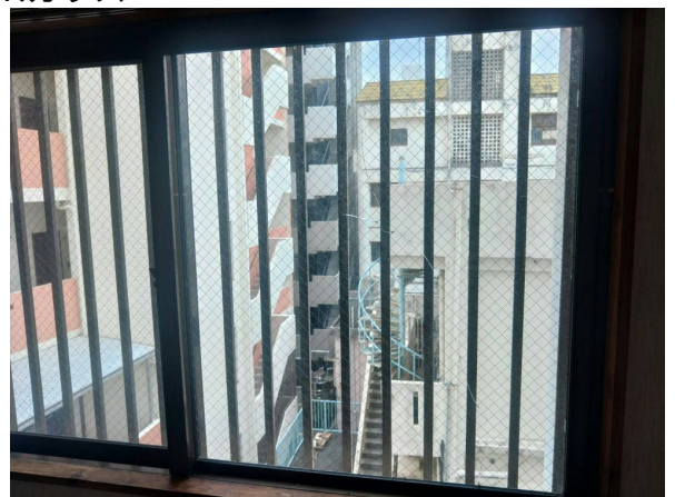
ガラス取替before
