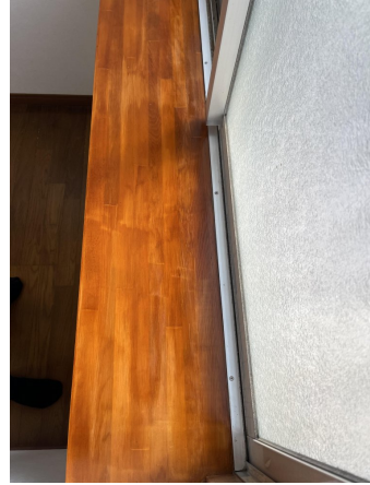
出窓研磨ニス仕上げ
