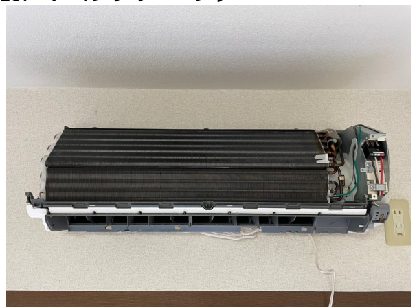
13.エアコンクリーニング
