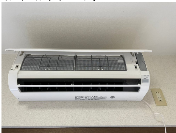
13.エアコンクリーニング
