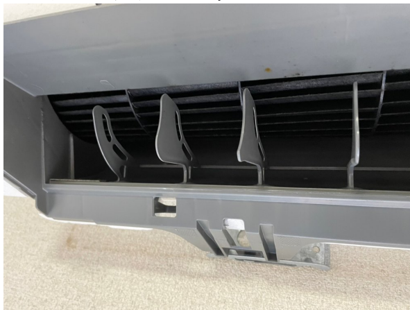
13.エアコンクリーニング
