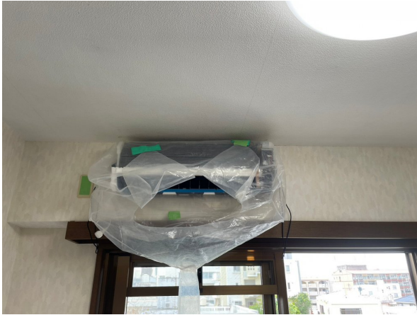
13.エアコンクリーニング
