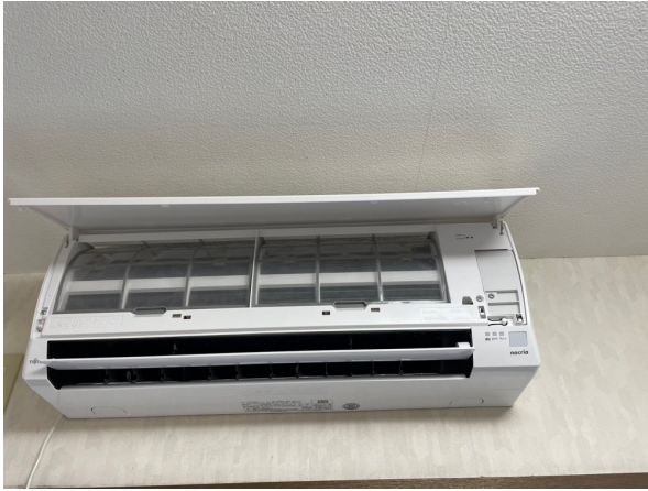
13.エアコンクリーニング
