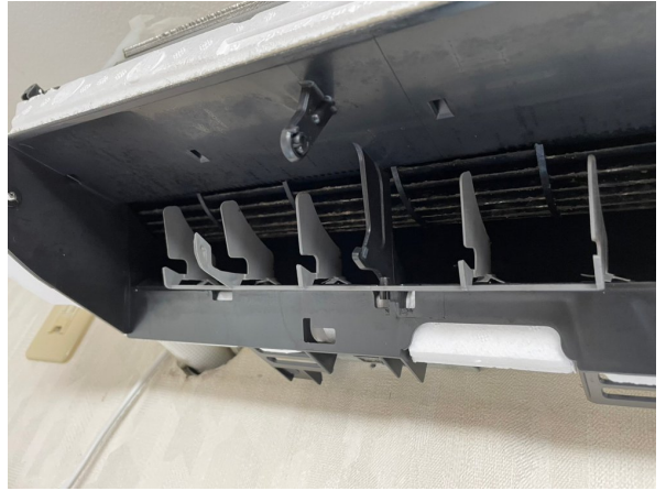
13.エアコンクリーニング
