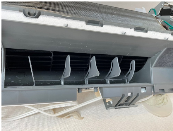
18.エアコンクリーニング
