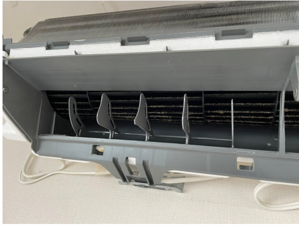
18.エアコンクリーニング
