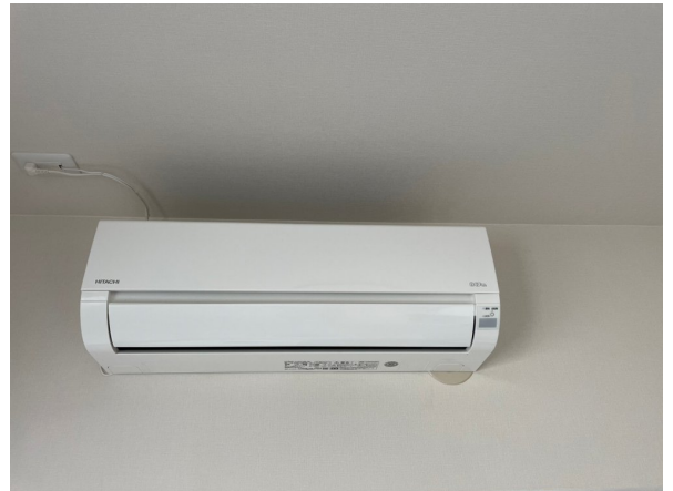
18.エアコンクリーニング
