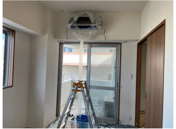
18.エアコンクリーニング
