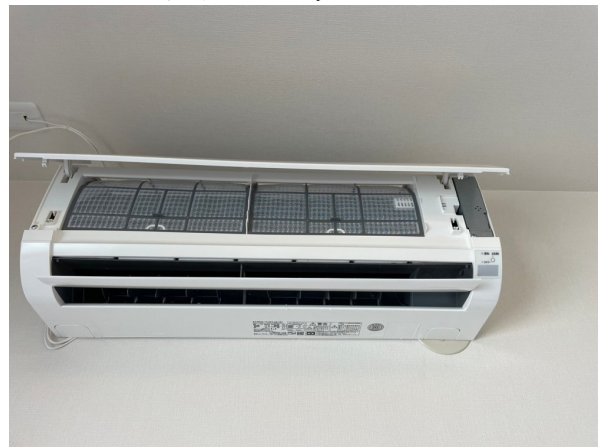
18.エアコンクリーニング
