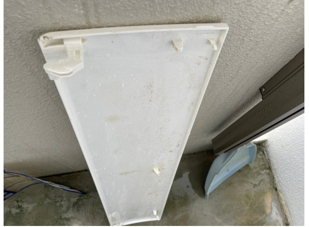
17.エアコンクリーニング
