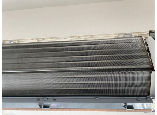
17.エアコンクリーニング
