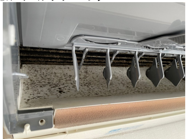
17.エアコンクリーニング
