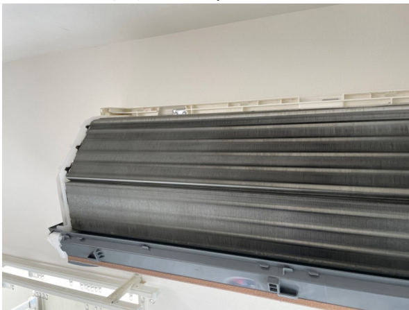
17.エアコンクリーニング
