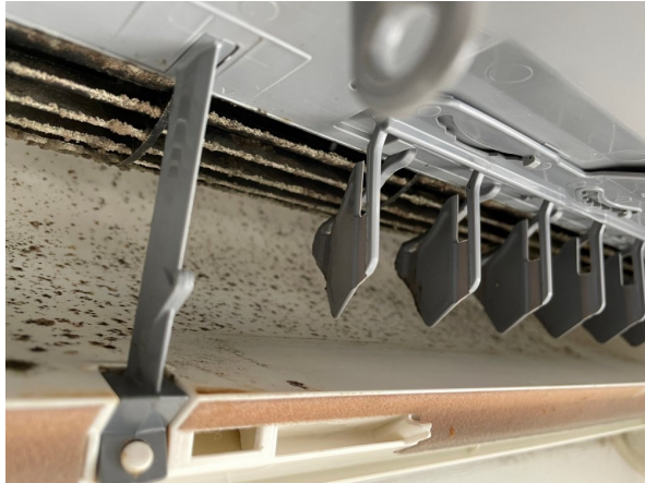
17.エアコンクリーニング
